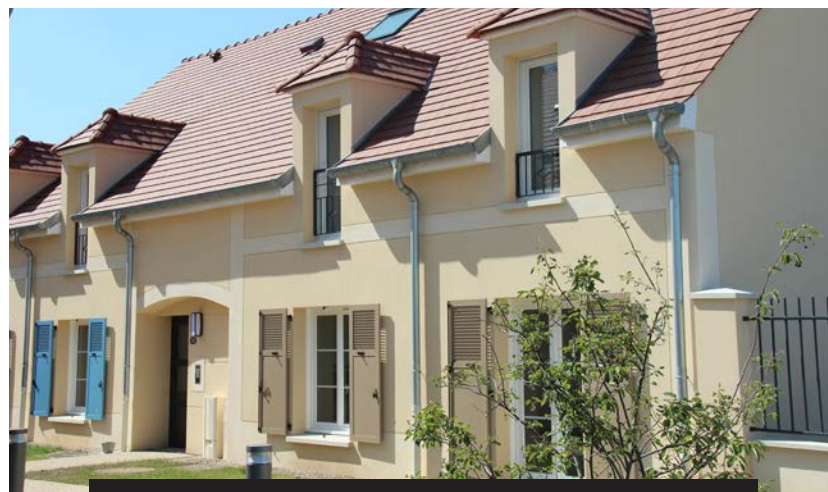
Livraison des logements rue du Trou Tonerre
