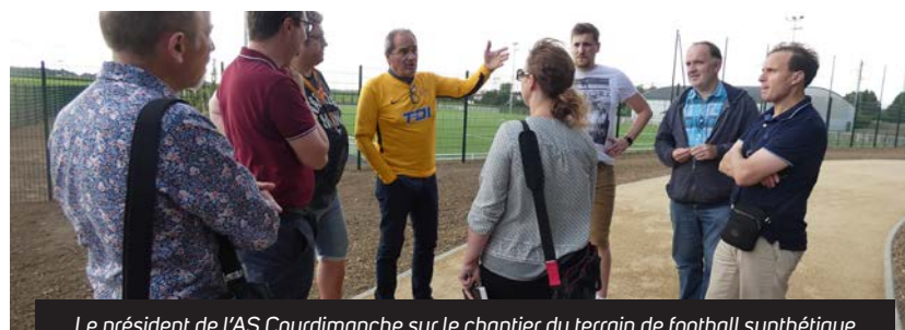
Le président de l'AS Courdimanche sur le chantier du terrain de football synthétique
