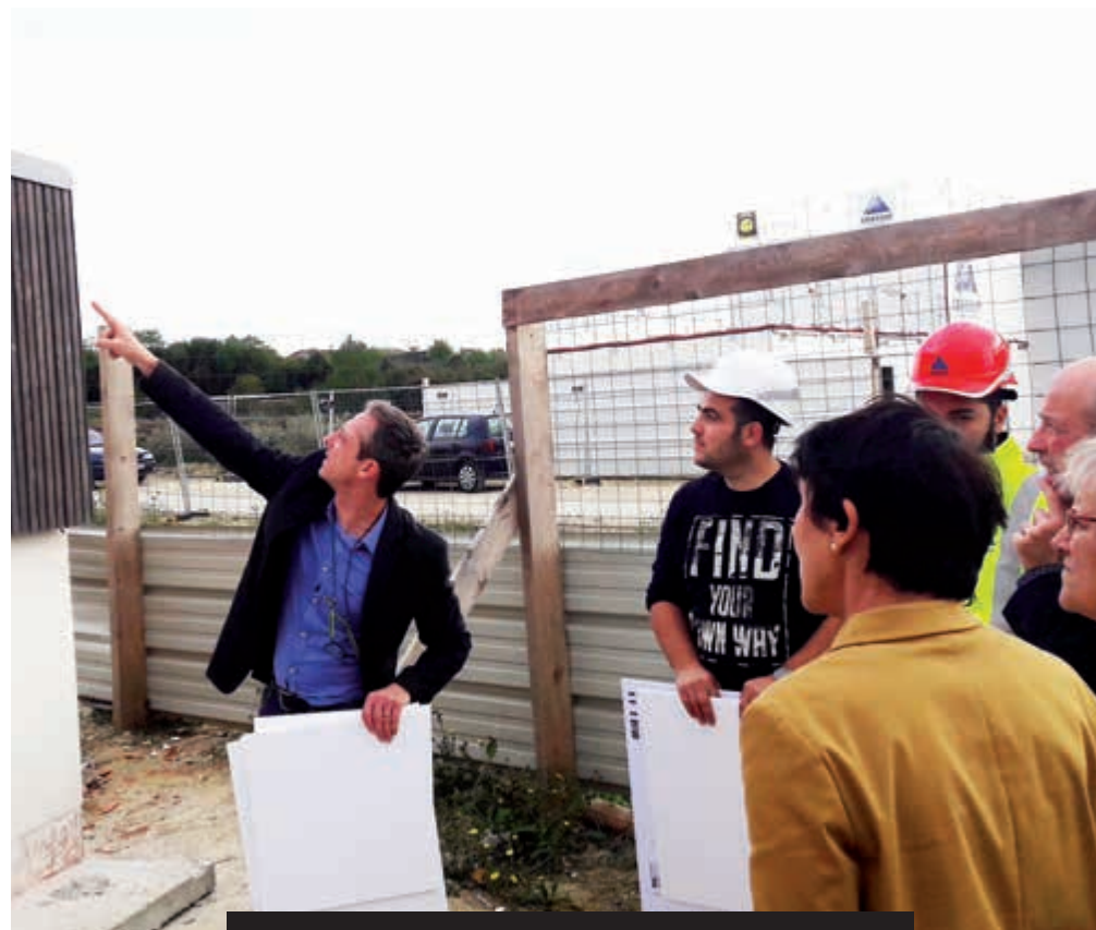
Visite du chantier de la zac du Bois d'Aton le 26 septembre
