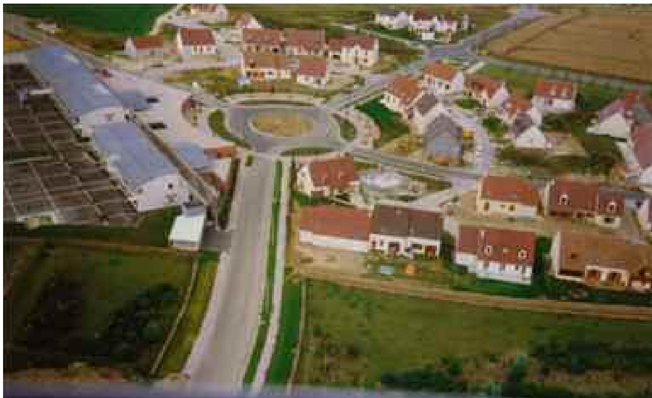
Les Croizettes et le Trou Tonnerre en construction
