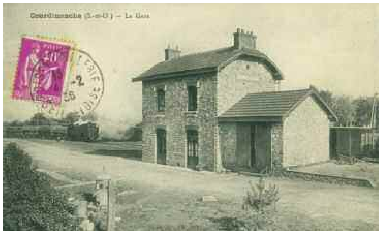
Rue du Maréchal Leclerc il y avait une gare. Aujourd'hui ce bâtiment est dédié à la petite enfance
