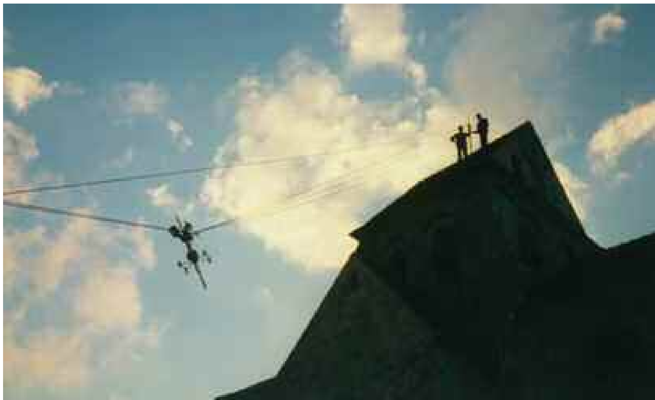
Installation du coq en 1990
