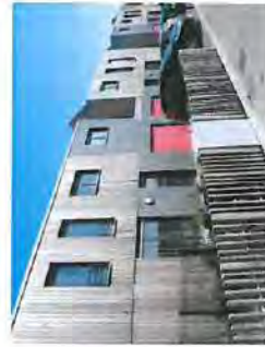
Clôture bois en bois avec muret technique intégré
