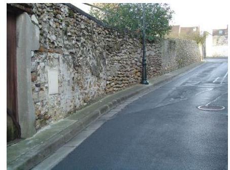
3 – Mur rue Charles Cavan
