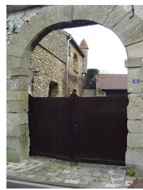
6 - Porche rue de la Grange Neuve
