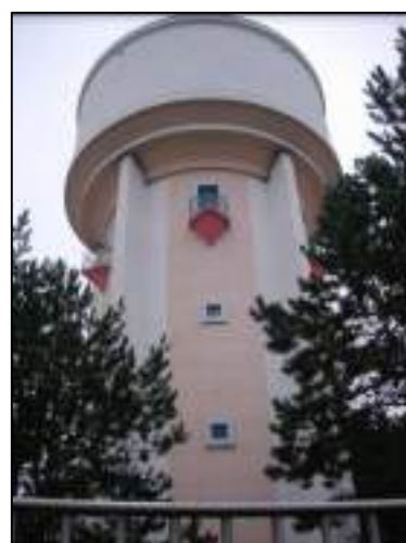
Réservoir de Saint-Ouen-l'Aumône rue du Parc 1000 m 3
