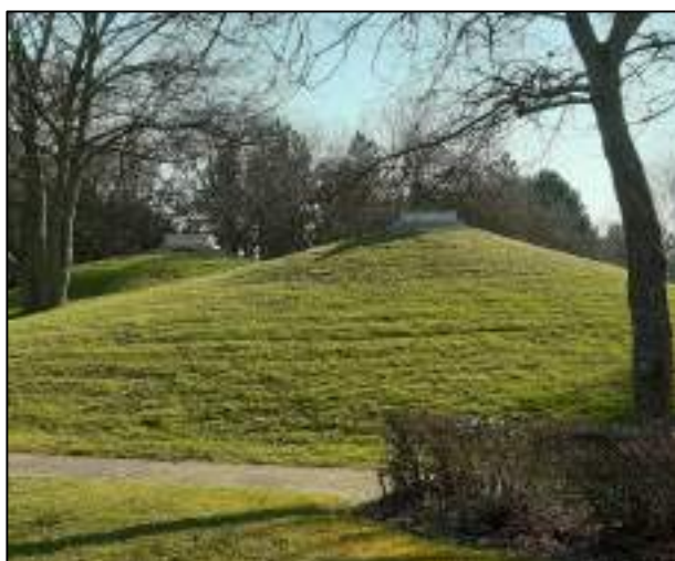
Réservoir de Cergy les Clos Billes
