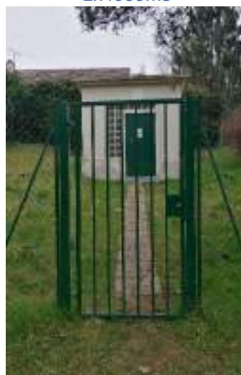
Relais de Boisemont 120m³, renouvellement du portillon
