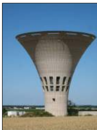
Réservoir de l'Oseraie Osny (2 x 2500m 3 )
