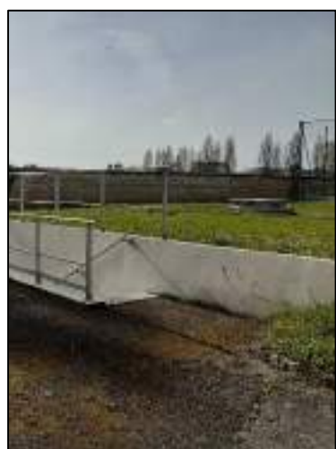
Réservoir de Pontoise rue Claude Debussy 1500 m 3
