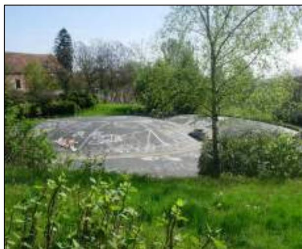
Réservoir de Boisemont 2 x 4000 m 3
