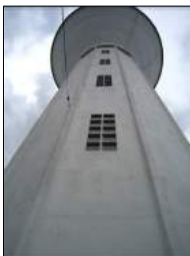
Réservoir de Saint-Ouen- l'Aumône rue d'Epluches 500 m 3
