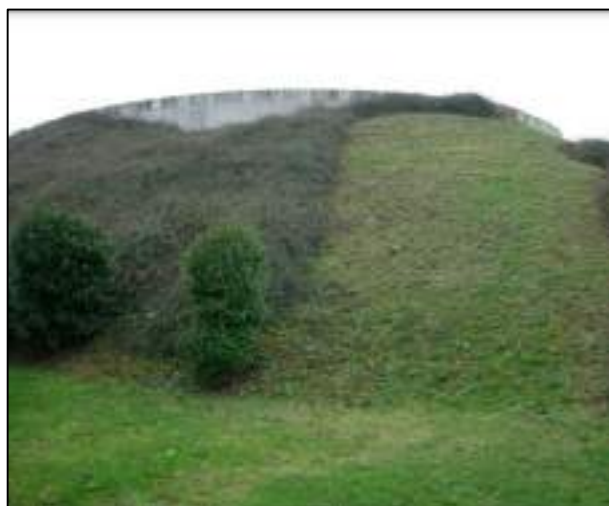
Réservoir du Bois d'Aton à Courdimanche 2500 m 3
