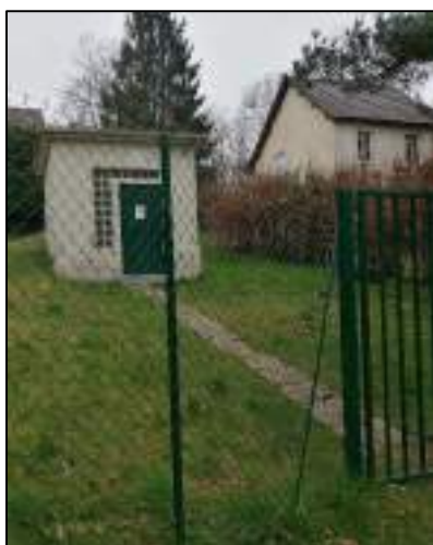
Réservoir Relais de Boisemont 120 m 3
