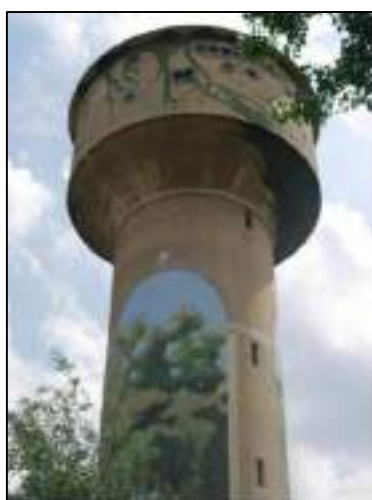
Réservoir d'Osny le Pigeonnier 1000 m 3
