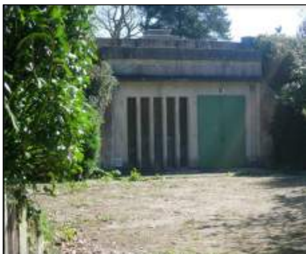
Réservoir de Boisemont 2 x 2000 m 3
