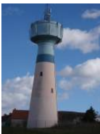
Château d'eau de Courdimanche
