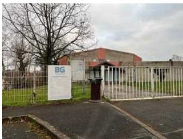
Réhabilitation en cours du foyer rural (centre d'accueil pour personnes âgées)
